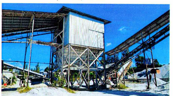
รูปที่ 14 ติดตั้ง Metal Sheet ปิดคลุมอาคาร โรงโม่หิน
