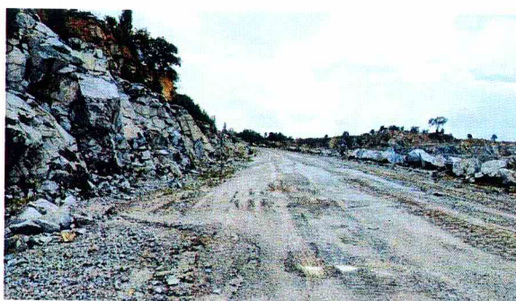
รูปที่ 5 เส้นทางลำเลียงแร่ ทำหน้าที่เสมือนคันทำนบป้องกัน น้ำให้ไหลลงสู่บ่อดักตะกอน
